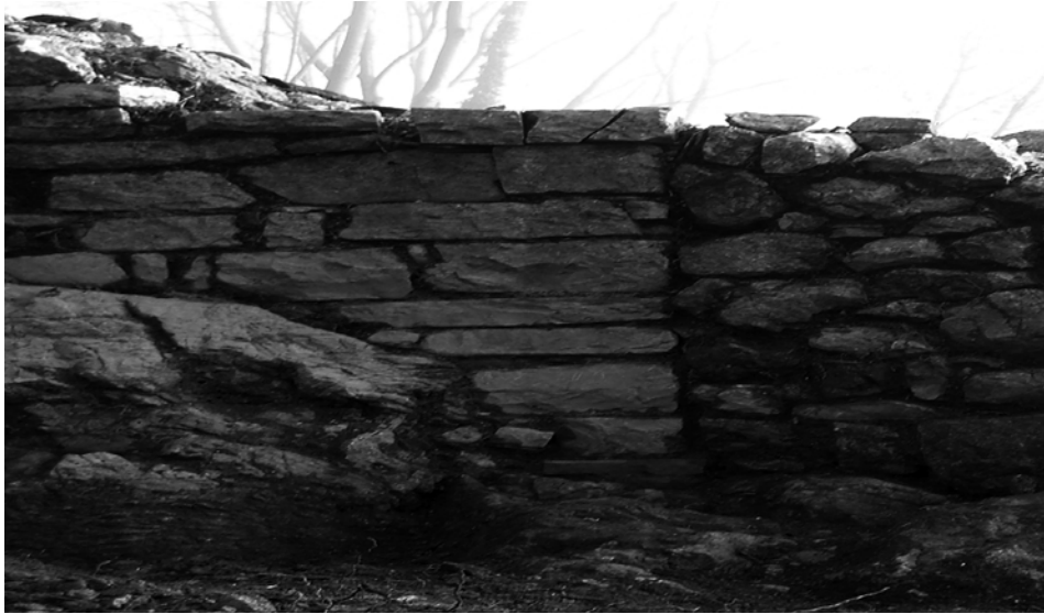
Fig. 3: Accesso nord, veduta da ovest (Fonte: Archivio ARAM, fotografia Ch. De Micheli Schultbess).
